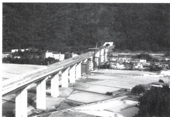
図8 ガイドウェイの高架橋建設状況
