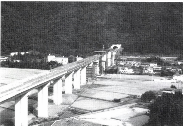
図8 ガイドウェイの高架橋建設状況
