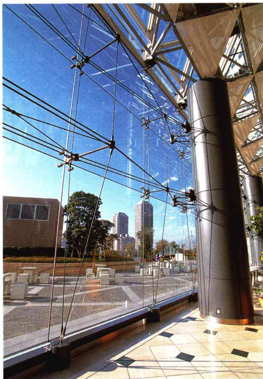
30ミリ、20ミリ、10ミリと太さの違う鋼製ロッドがつなぎ合わされたテンション構造で、壁面の美しさを出しながら同時に力の流れを表現している
