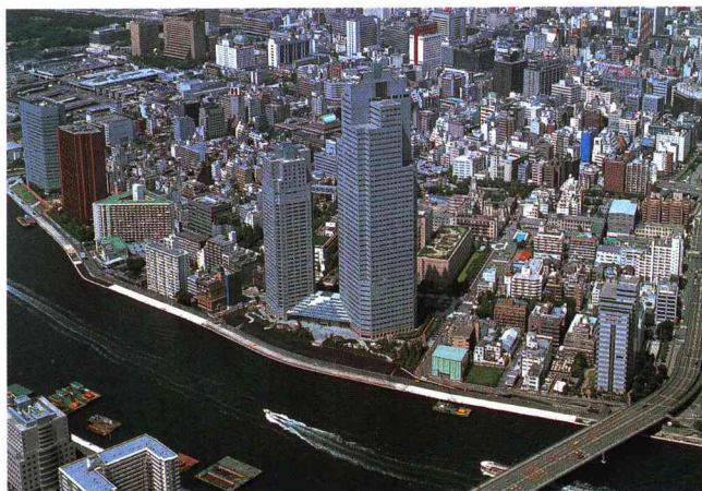
2つのビルと独特のフォルムが特徴の聖路加ガーデン [設計：日建設計／施工：鹿島建設・大成建設・大林組・清水建設・前田建設工業共同企業体]
