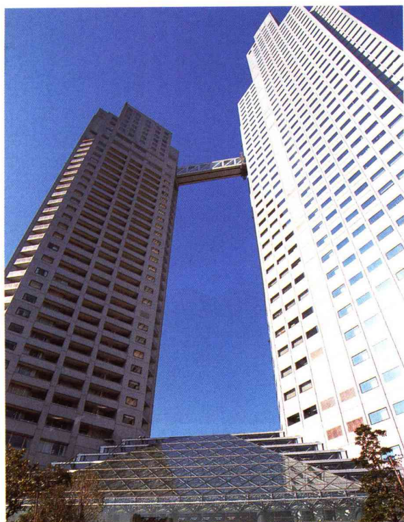
地上110メートルの高層ブリッジは鉄骨トラスのチューブ構造
