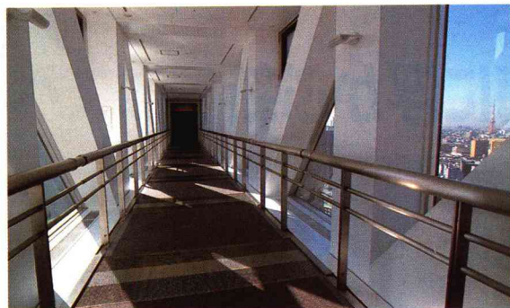
高層ブリッジの床面はパネルと櫛状の継ぎ目で伸縮できるようになっている
