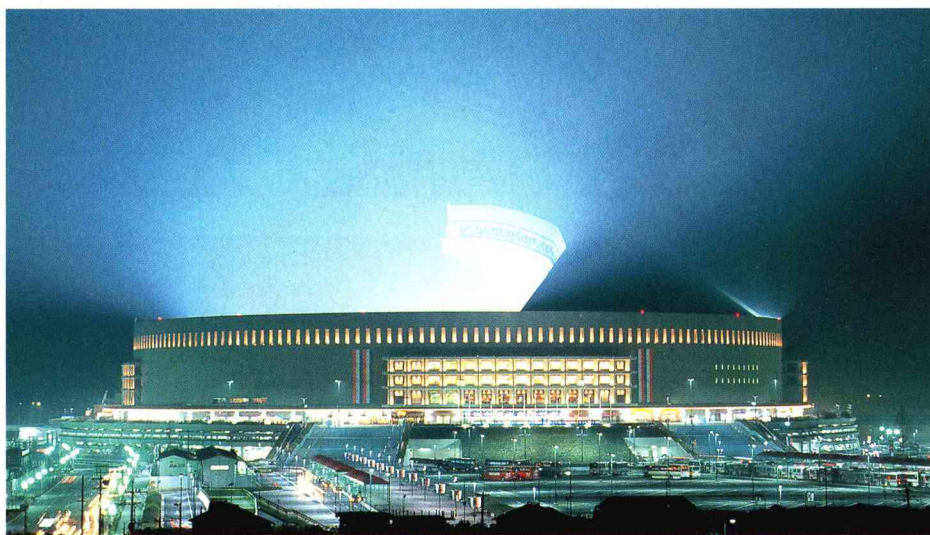
ドームの最高部は84メートル、屋根の直径は212メートルにもおよぶ。この巨大な屋根が、円周の壁だけで支えられている
