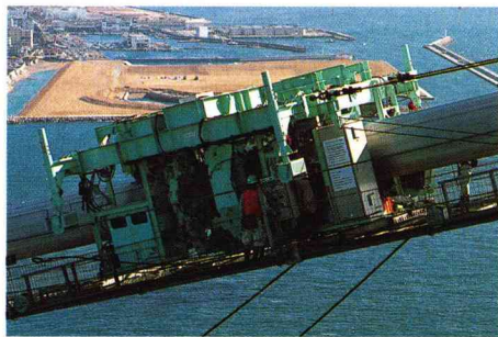
290本のストランドを圧縮して丸い断面に仕上げるスクイジング・マシン。大震災が襲ったのは、この工程に入った時だった
