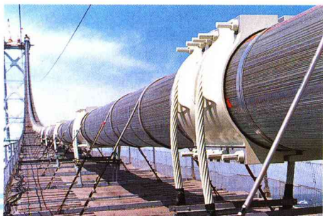
1本にまとめられたケーブル。さらに被覆と塗装による防食が施されて完成する。下にみえる木の部分はキャット・ウォークと呼ばれる足場
