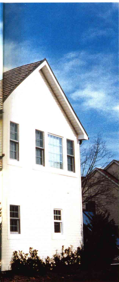
NAHBにおけるデモンストレーションスチールハウス
