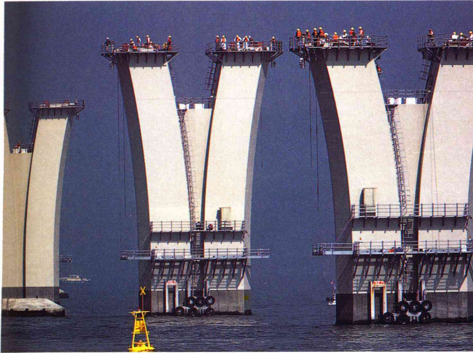
景観との調和を配慮し、曲線にこだわってデザインされたという鋼製橋脚（設置直後）
