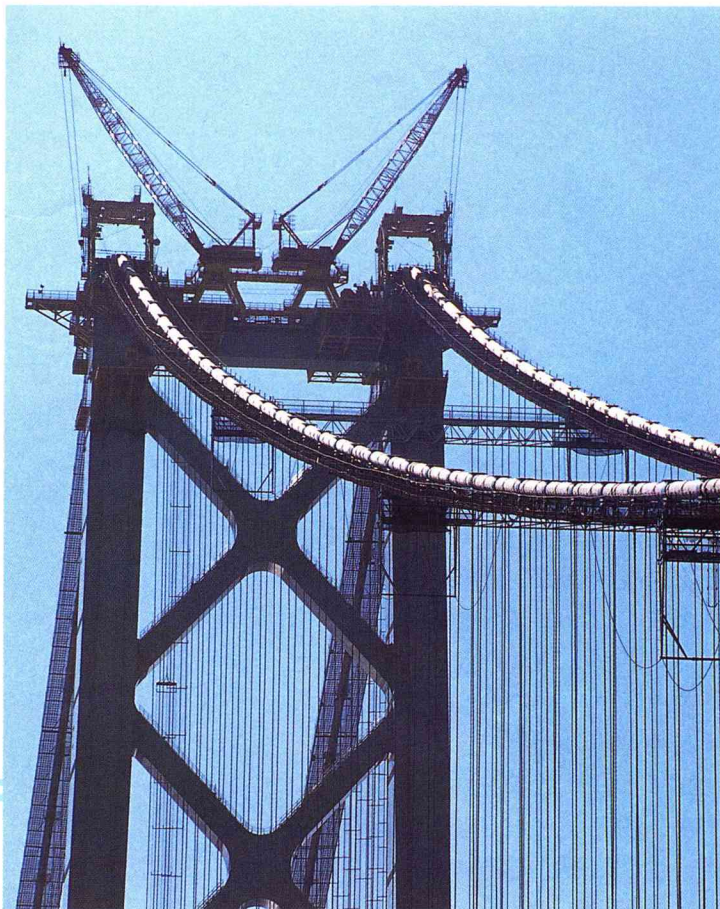
主塔にもSM570、SM490Y、SM400といった高強度鋼材が使用されている。鋼材の重ね面どうしはメタルタッチ（金属面どうしがピッタリと接触している状態で、本四公団の基準では隙間0.04mm以下）が94%以上という高度な加工技術によって仕上げられている。また揺れを緩和するため主塔のところどころには特殊な制振装置が組み込まれている
