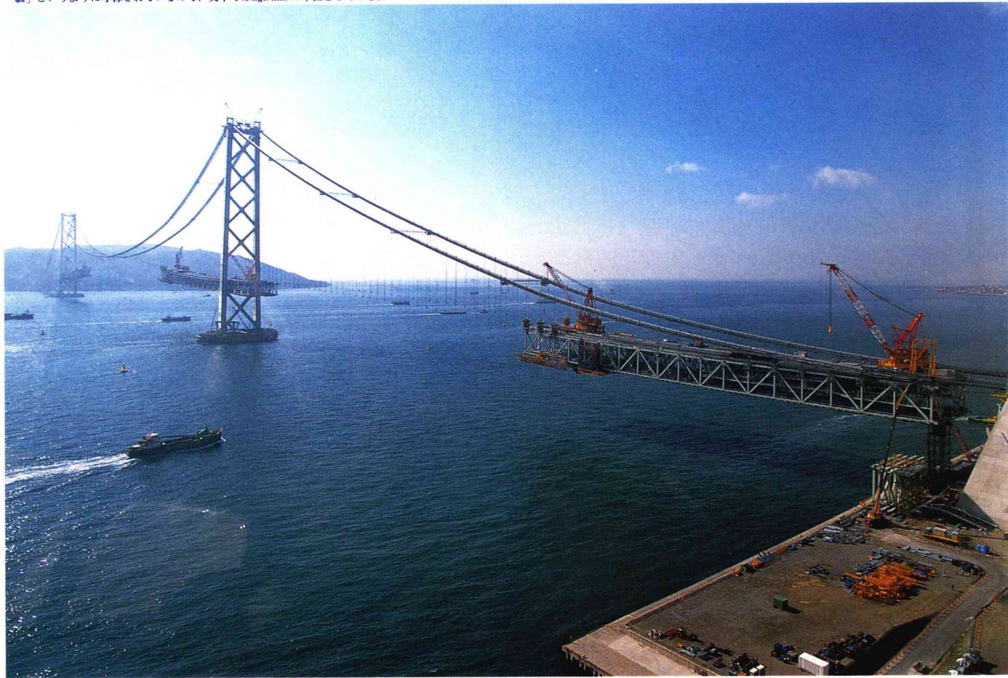
180 \text{kgf/mm}^2 の高張力ケーブル素材が、この壮大な計画を支えている（神戸側より撮影）
