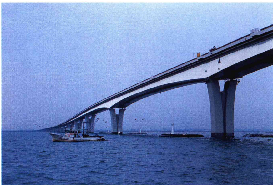
南側から見た東京湾横断道路・橋梁部分（建設中）。左手がトンネルへと通じる木更津人工島、右手が木更津市側
