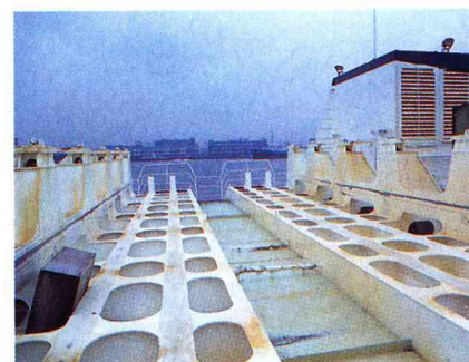
甲板に設置された台車用レール
