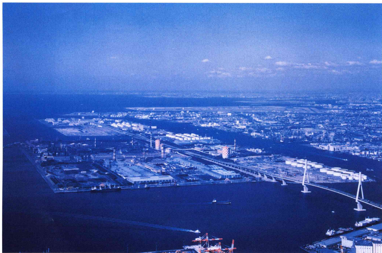
川崎市沖の人工島「扇島」にあるNKK京浜製鉄所の全景
