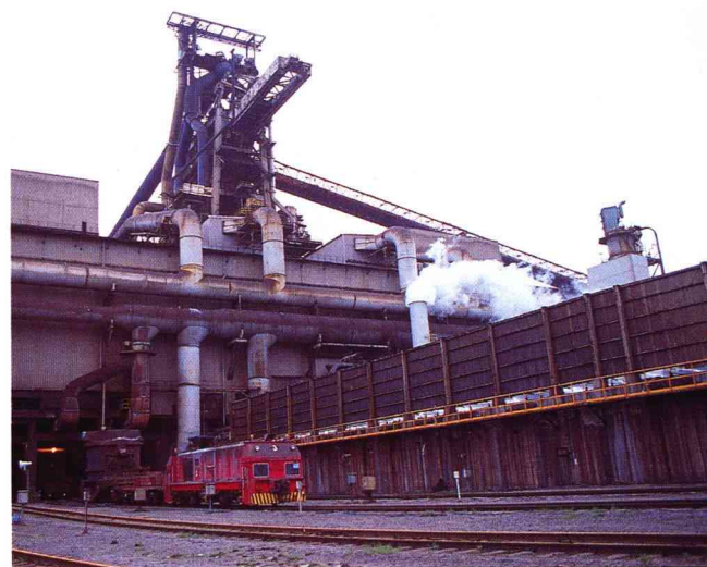
建屋集じんになっている高炉
