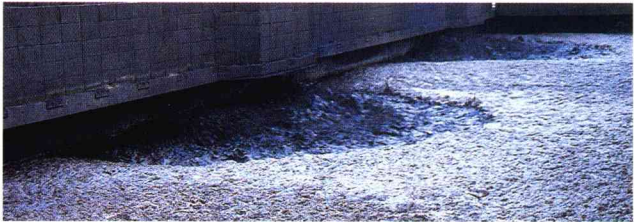
バクテリアによる処理を行う活性汚泥処理槽
