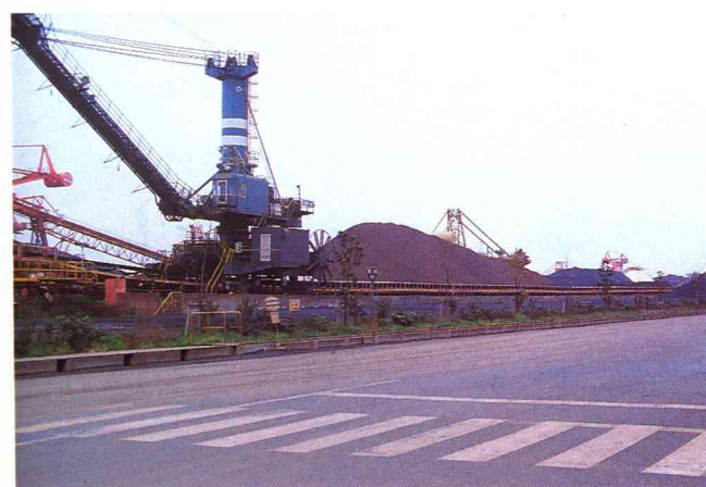
粉じんを防ぐ工夫がされた原料ヤード
