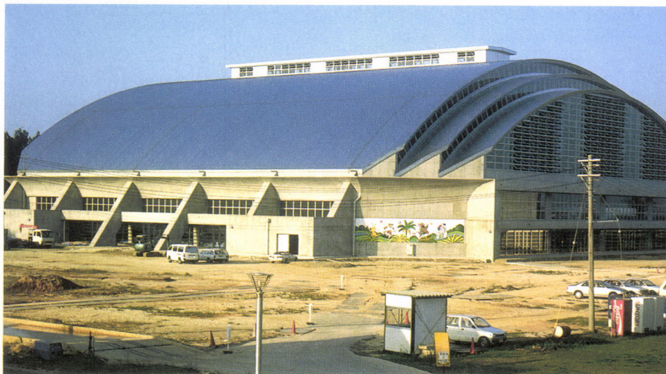
図2 22Cr-1.2Mo高耐熱性フェライト系ステンレス鋼の屋根施工例 (沖縄総合運動公園屋内運動場) 12)
