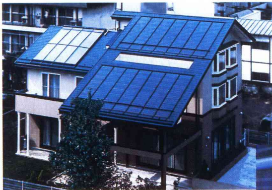
断熱パネル方式の住宅用太陽電池。温度上昇によるアモルファス太陽電池の劣化改善もねらって、研究開発中
