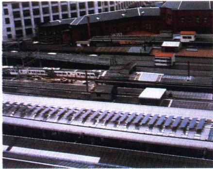
東京駅東北・上越新幹線ホーム／30 kW
