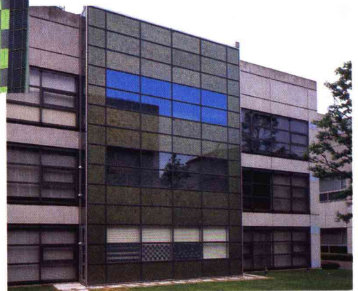
ビル壁面への設置を可能にするガラスカーテンウォール方式。左は窓などに取り付けて透過光を利用できるタイプ。
