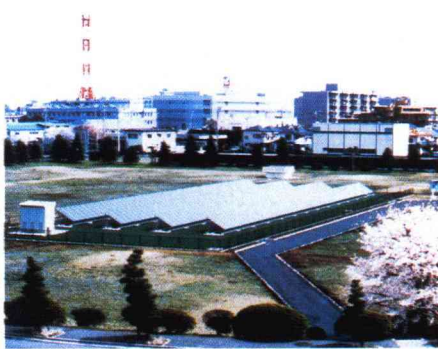
東京都水道局東村山浄水場／70 kW（東村山市）
