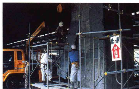
首都高速道路における耐震補強工事
