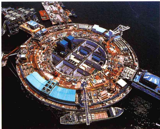
■工事進捗率約83%に達した川崎人工島
