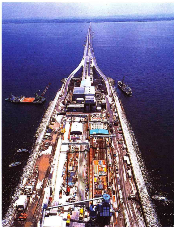
■建設途中（H8.5月現在）の木更津人工島。
