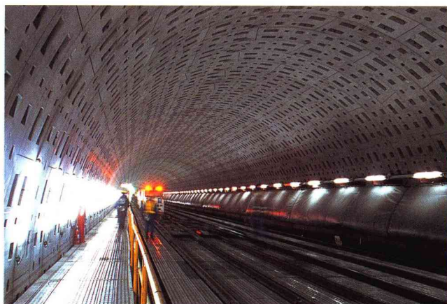
■密閉型シールド工法で建設されたトンネル部分。
