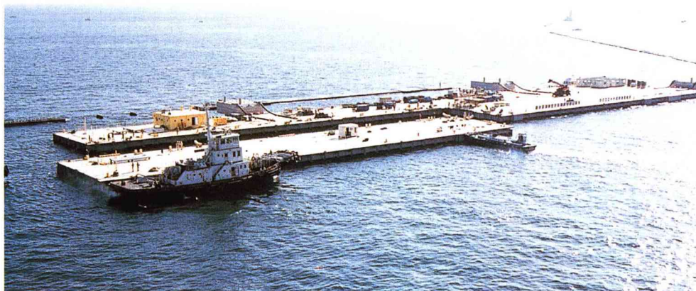
メガフロートの接合実験（横須賀沖）
