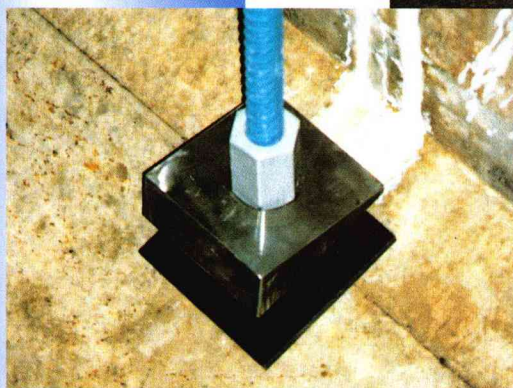
床板とPC鋼棒の接着部
