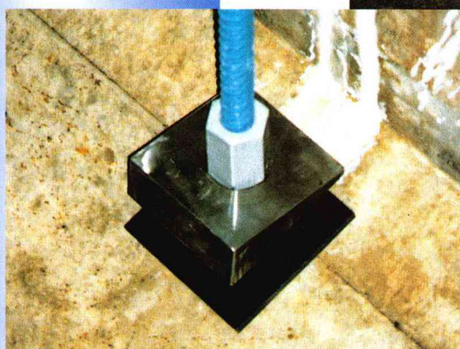
床板とPC鋼棒の接着部
