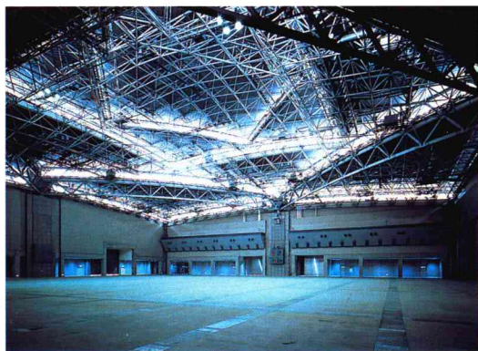
東展示ホール：鉄骨構造の吹き抜け天井
