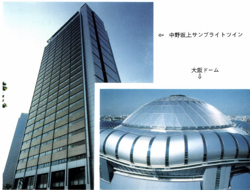
図4 高耐食性フェライト系ステンレス鋼を使用した建築物
