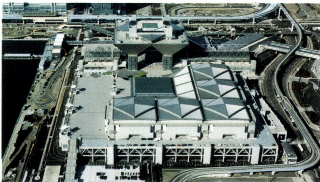
図5 アルミメッキステンレスを使用した 東京ビッグサイト展示場
