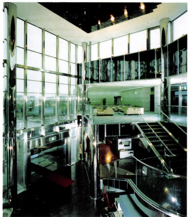
図6 ステンレス鋼を構造材として適用した建築物 (新日本製鐵株君津テクノロジーセンター)
