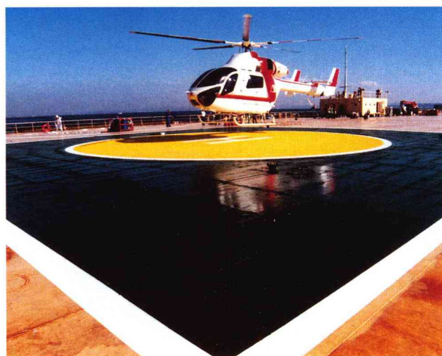
神奈川県横須賀沖に設置されたメガフロートの実験モデル。昨年7月の接合実験の様子（上）。昨年11月に行われた中型ヘリコプターの離発着実験の様子（下）。
