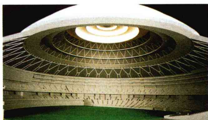
スーパーリングを最上部に設定し、自然採光でスポーツなどを行う場合
