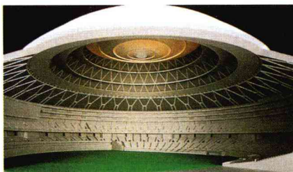
スーパーリングを降下させ、遮光状態でスポーツなどを行う場合
