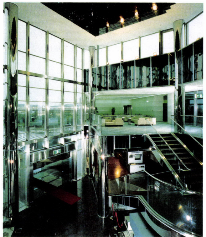
図6 ステンレス鋼を構造材として適用した建築物 (新日本製鐵㈱君津テクノロジーセンター)
