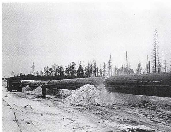
図8 フラッシュバット溶接による大径鋼管の現地円周溶接
