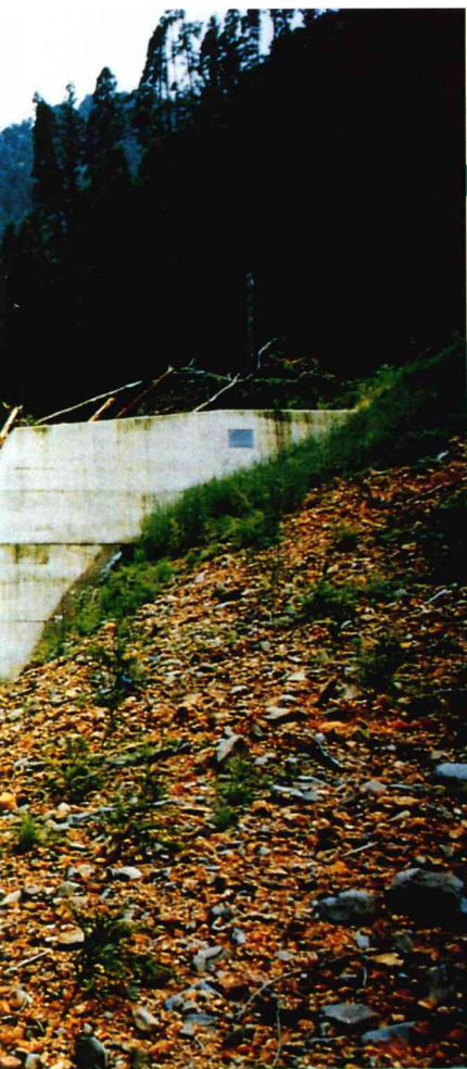
■銅製スリットダム
