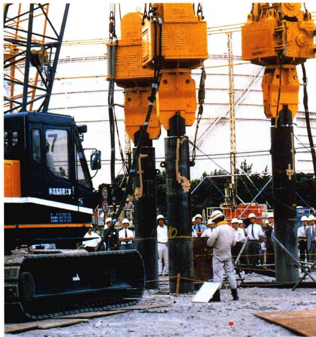
■地震による地盤の液状化を防ぐための鋼管杭埋設工事
