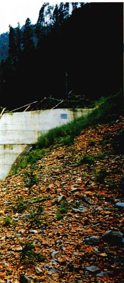
■銅製スリットダム
