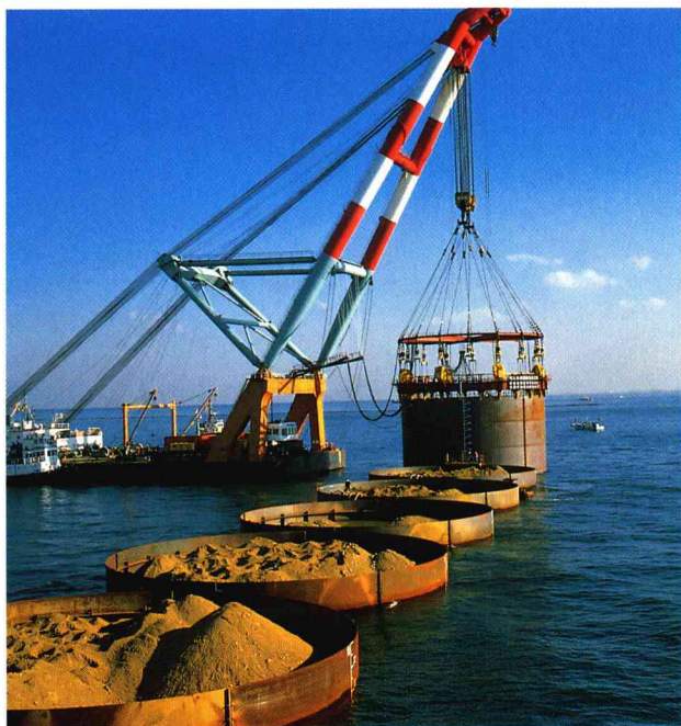
■護岸用セル打設
