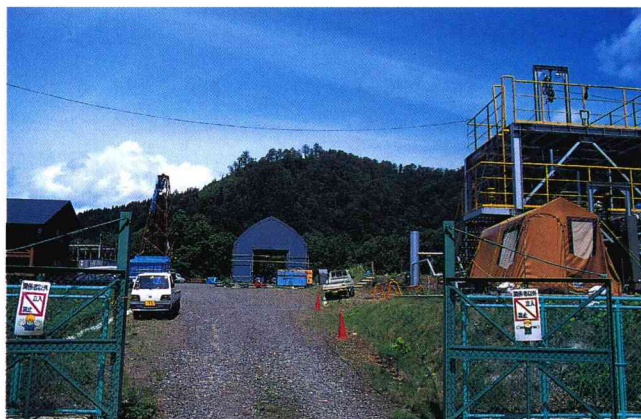
雄勝実験場の全景。左奥のやぐら(注入井)から水を注入し、右手前のやぐらから熱水と蒸気を取り出している(生産井)。中央に見える小屋はポンプ室
