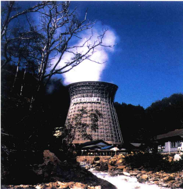
日本で最初の本格的地熱発電所である日本重化学工業・松川発電所。30年にわたり安定した稼働率で運転が続けられている（23,500kW）
