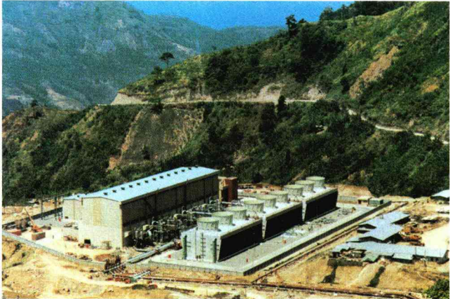
フィリピンのパリンピノンにある地熱発電所（写真提供：富士電機）
