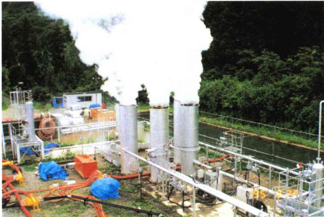
NEDO 肘折実験場での高温岩体発電の実験風景。蒸気が盛んに噴出している
