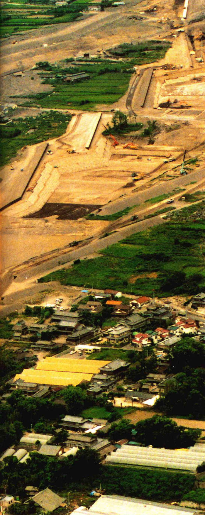
土石流などの土砂への防波堤として築かれた仮設導流堤の全景(左)と近景(上)。
