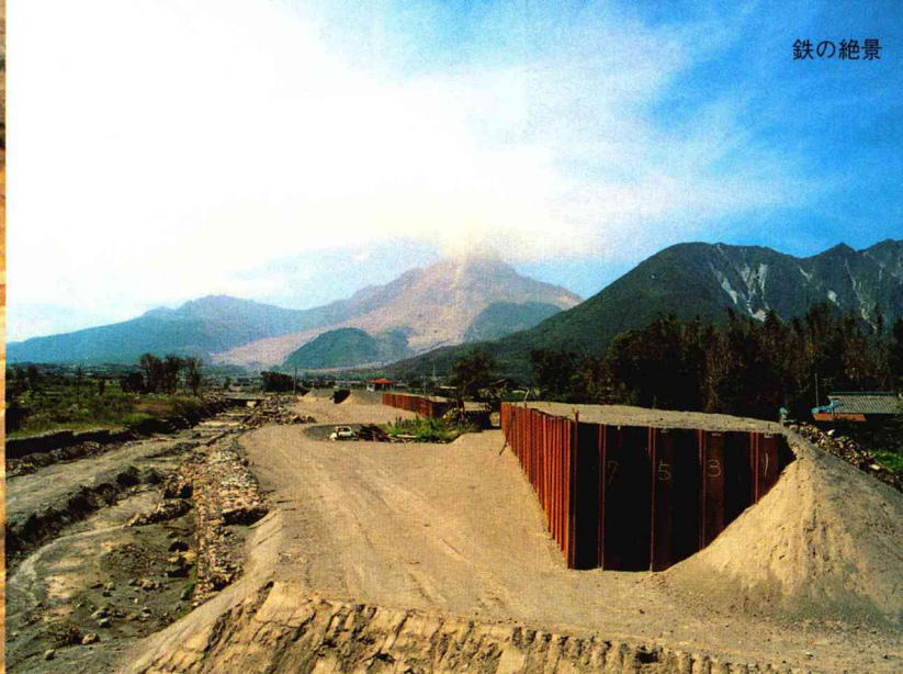
土石流などの土砂への防波堤として築かれた仮設導流堤の全景(左)と近景(上)。
