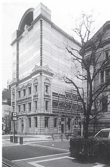
図4 旧川崎銀行横浜支店（現日本火災横浜ビル）1922年 設計矢部又吉 1989年、いったん解体の上石造外壁を復原、内部と上階を新築した 設計日建設計
