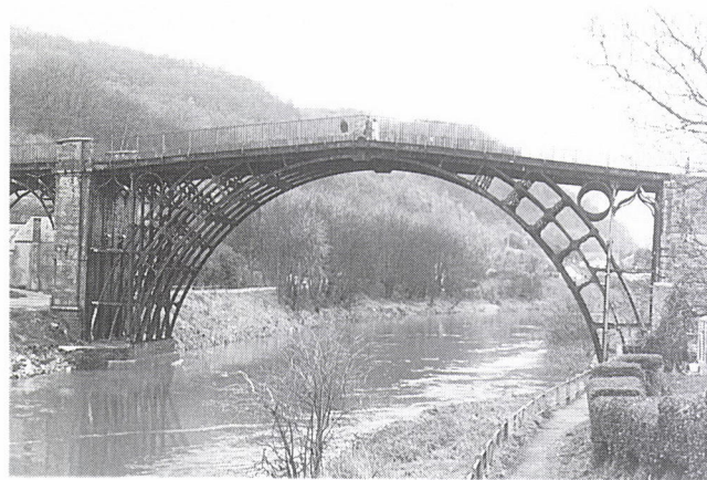
図1 世界最古の全鉄製の橋「アイアンブリッジ」(1779)
