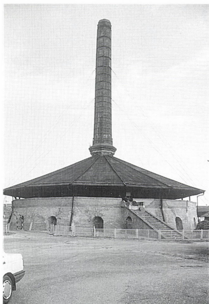
図2 下野煉化製造会社ホフマン式輪窯 1890年 栃木県 1979年国重要文化財に指定された
