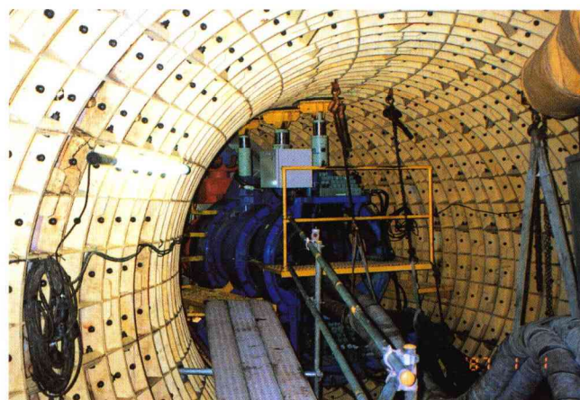
スパイラル・トンネルの内部を固めるスチール・セグメント。ジオドームを支える重要な鉄の技術である。
