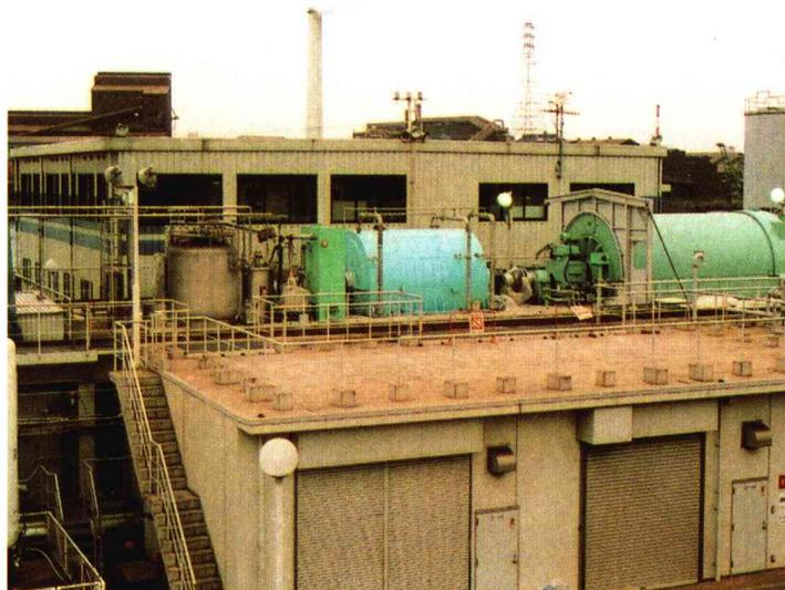
7万kW級超電導発電機（モデル機）。
