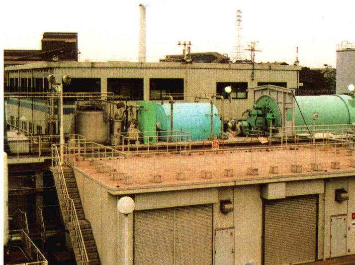
7万kW級超電導発電機（モデル機）。
