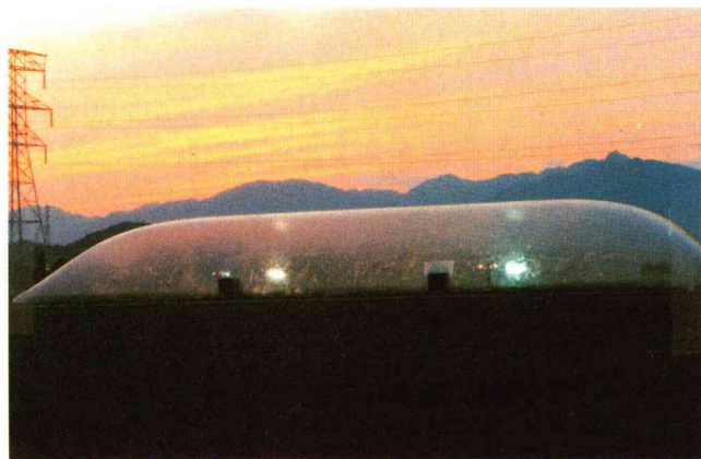
三重県にある神前ライスドームの全景。52m × 19m × 5m。
