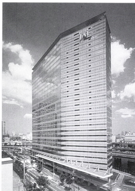
図7 制震装置(オイルダンパ)を組み込んだJAL本社ビル
