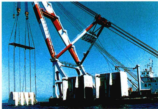
人工湧昇流発生構造物とその設置風景。
