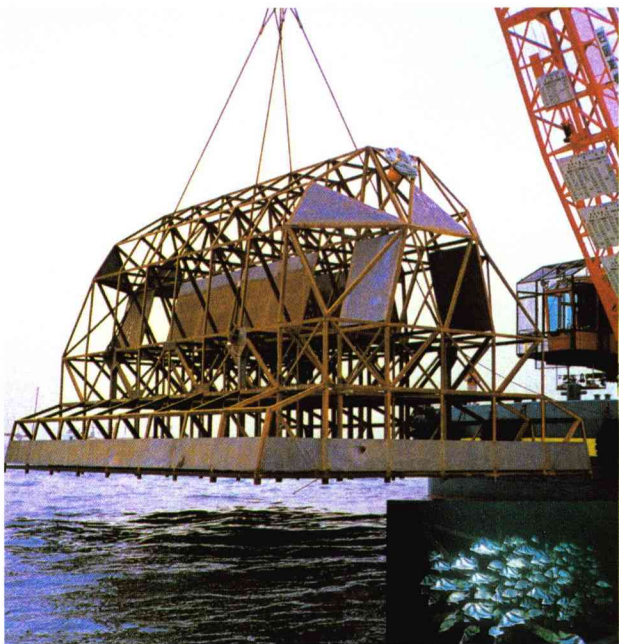
さまざまなタイプの鋼製魚礁。自由な形状に設計でき、大規模なものの建造が可能。
