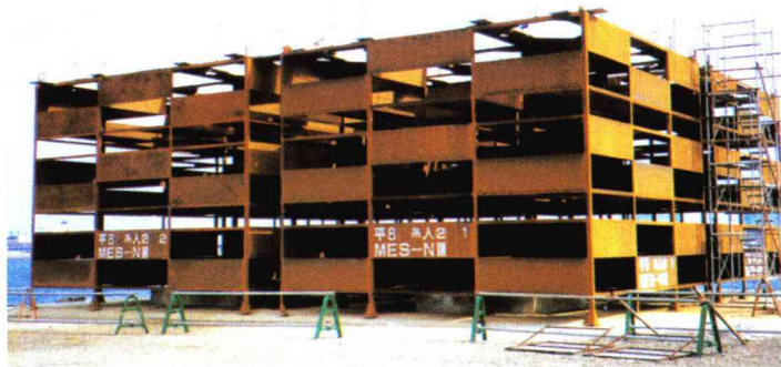
さまざまなタイプの鋼製魚礁。自由な形状に設計でき、大規模なものの建造が可能。
