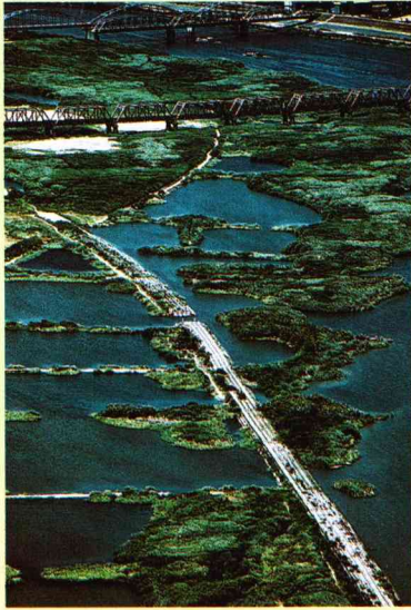
京都府・大阪府を流れる淀川のコンクリート水制とワンド（写真：河川環境管理財団）
