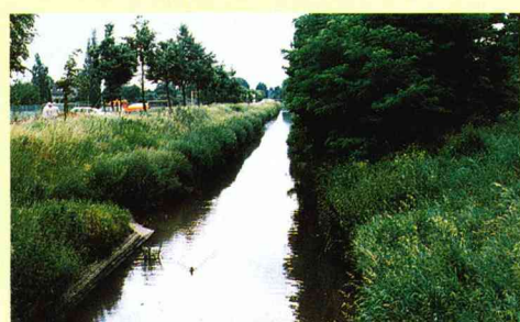
施工前（写真提供：建設省河川環境課）
