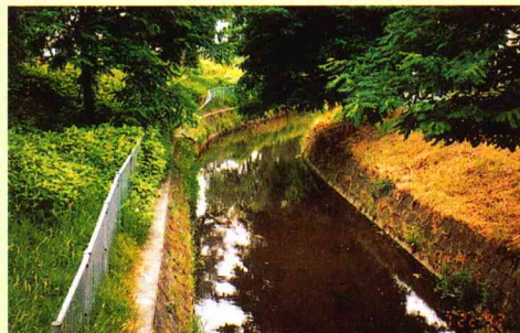
施工前(出典:財・リバーフロント整備センター編著『まちと水辺に豊かな自然をIII 多自然型川づくりの取組みとポイント』山海堂)
