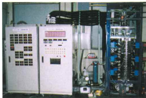
固体高分子電解質水電解法の試験設備 (2500cm 2 セル評価試験設備)。
