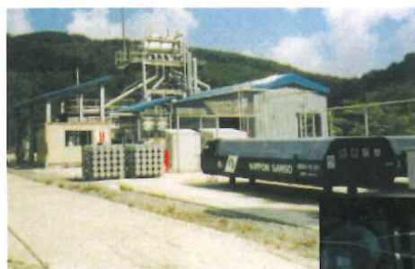
水素-酸素燃焼試験設備 (秋田県)。
