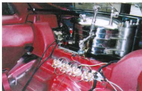
車内から見た 8号車の水素 タンク。
