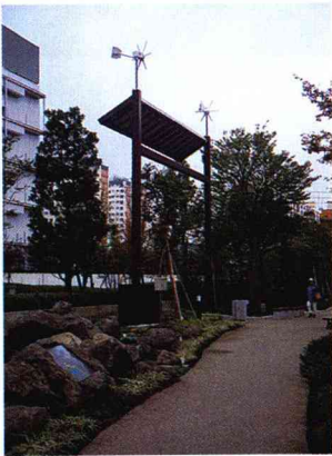
太陽電池と風力を組み合わせた水循環のための発電装置（エコピア蓮根）。
