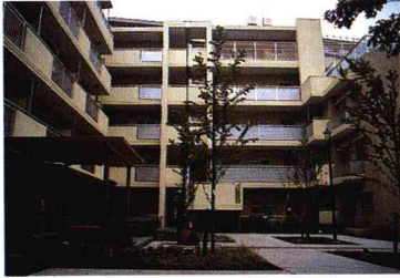
南側エントランスから見たエコピア蓮根の外構。
