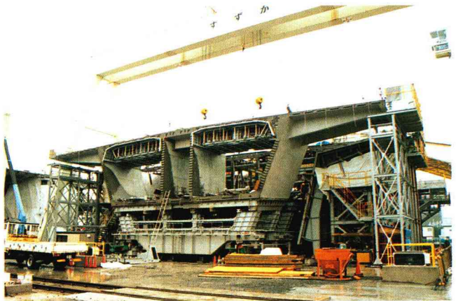
型枠から外されるセグメント。
