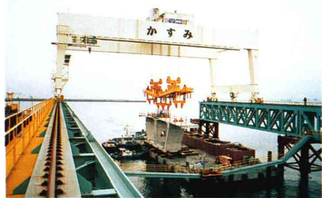
海上輸送のための「浜出し」の作業。
