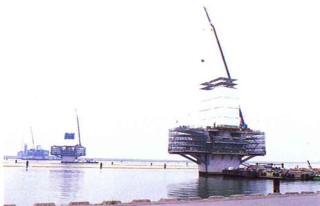
立ち並ぶ橋脚（取材時）。
