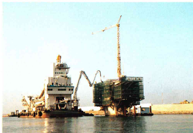
CP 船による主塔のコンクリート打設。
