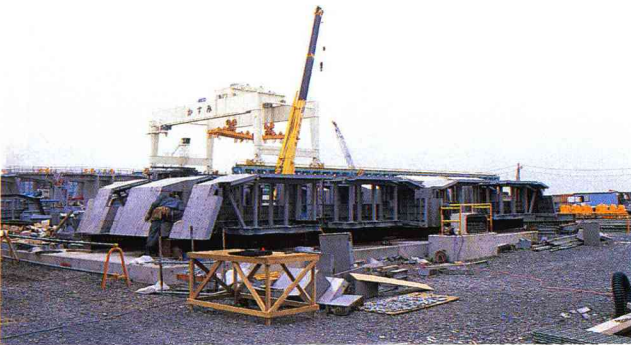
製作ヤードに並ぶセグメント用型枠の一部。
