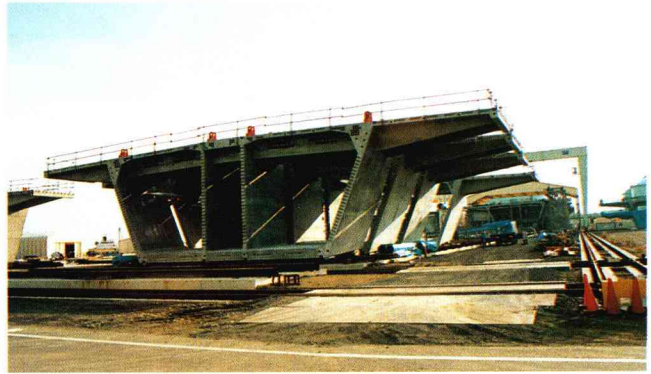
製作ヤードに並んだ各セグメント。
