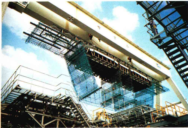
セグメントの鉄筋据え付け。最外周部のみ海水対策としてエポキシ樹脂による防食塗装が施されている。
