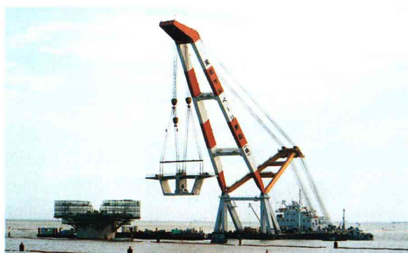
クレーン船による橋頭部セグメントの据え付け。
