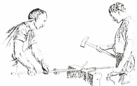
図15 鍛冶屋と助手がスケルプをコアチューブとマンドレルに巻きつけているところ 1)
