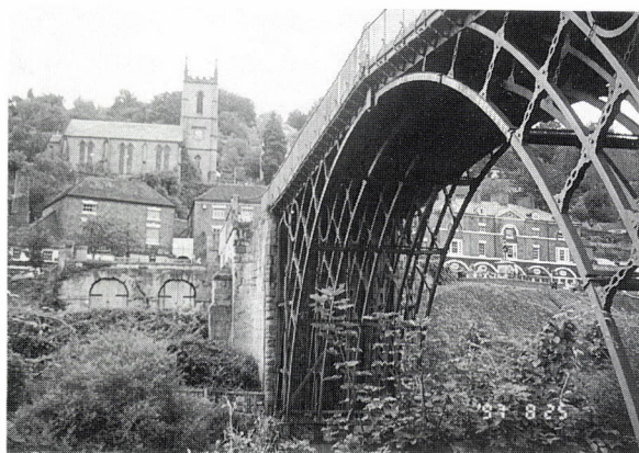
図19 世界最初の鉄骨構造 アイアンブリッジ 製作者：アブラハム・ダービー三世(1779年)
