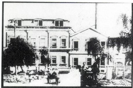
図25 日本最初の鉄骨造 秀英舎印刷工場 設計：若山鉞吉 鋼材：フランス製(1894年)
