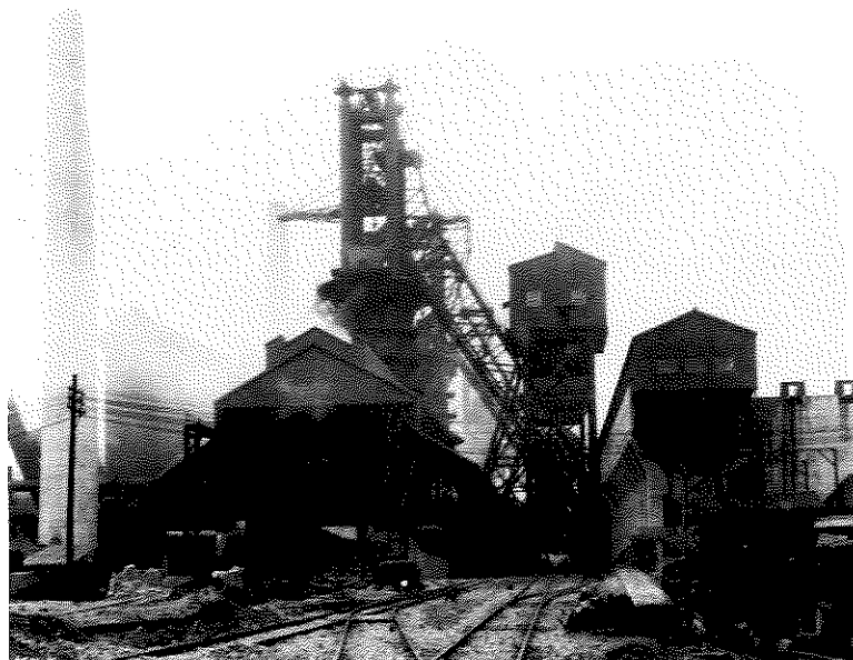
最初の純国産1000トン炉である洞岡第4高炉全景（1938）。
