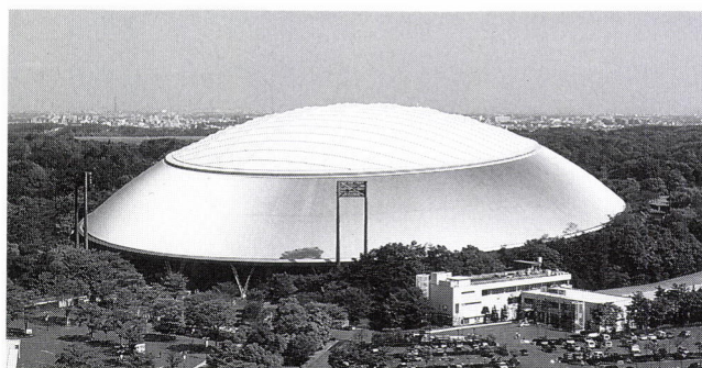
図4 SUS445J1(22Cr-1.2Mo-Nb-Ti-Al)を用いた西武ドーム球場の屋根
