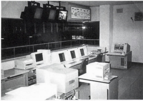
図7 日新製鋼 東予製造所冷延ミル運転室内
