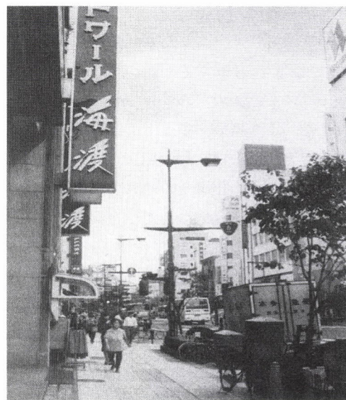
図7 キャブ整備後の一般国道6号馬喰町
