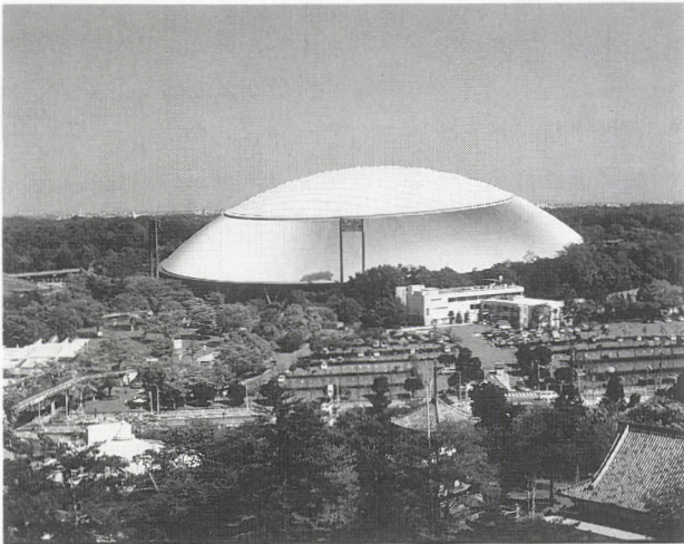
図3 西武ドーム(使用材料：22Cr-1.2Mo+有機皮膜処理)
