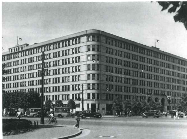
日本で初めて耐震構造理論を取り入れて建設された丸ビル。
